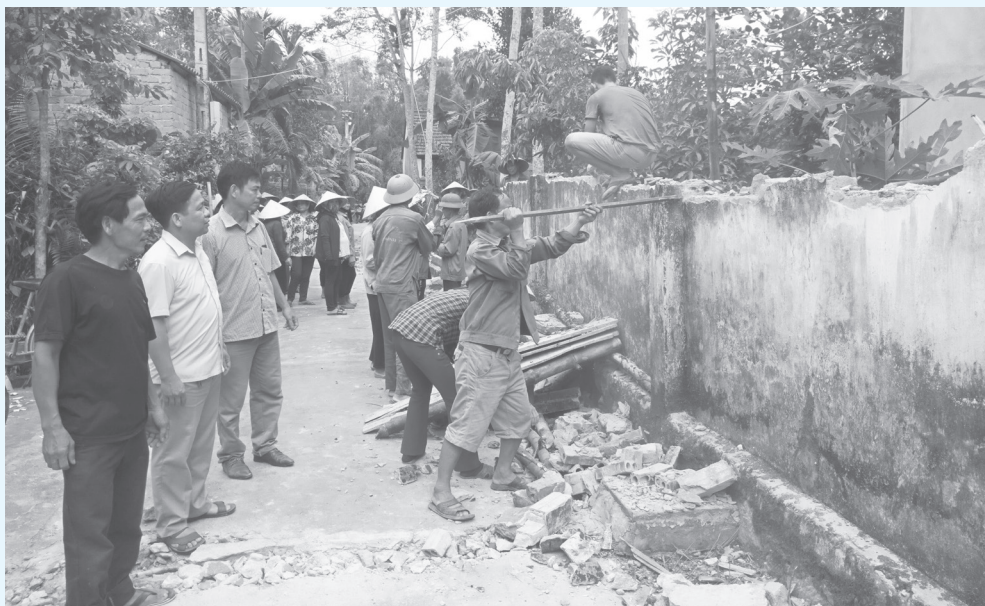
Người dân thôn 3, xã Sơn Bình tự nguyện phá dỡ tường rào, hiến đất mở đường.
